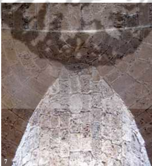
8. Noto. Convento dei Cappuccini, volta lunettata in pietra bianca d'intaglio e pietra detta "tufigna", 1705.
