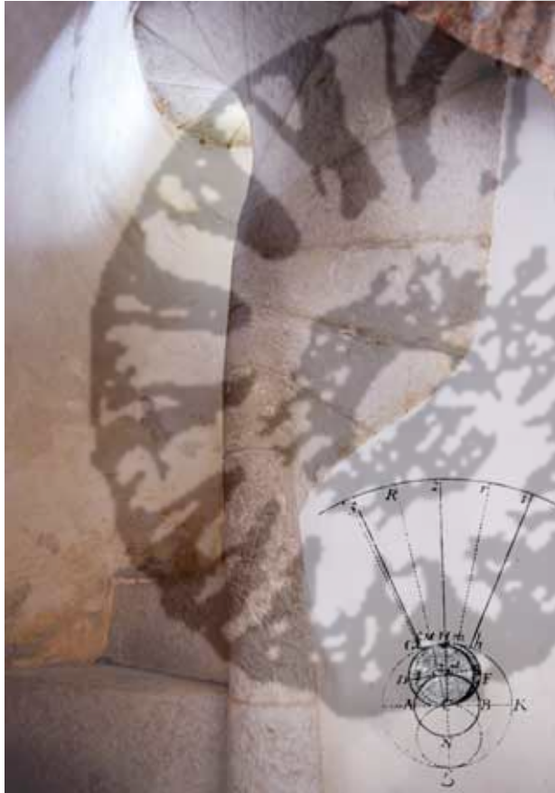
1. Setúbal (Portogallo). Chiesa del Gesù, scala a chiocciola con nucleo centrale "fuori asse", XVI secolo, con sovrapposto disegno di scala con «noyeau rampant» (da A. F. Frezier, La théorie... , cit.).
