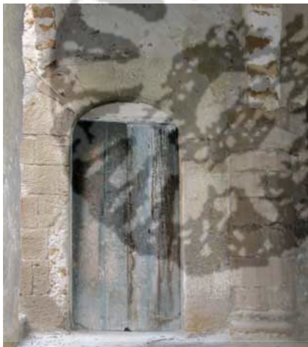
3. Particolare del cortile con il semipilastro poligonale.
