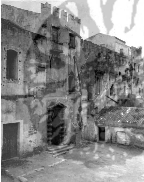
1. Palermo. Castellammare, corpo turrato della scala nella residenza di Ferrante Gonzaga progettata da Domenico Giunti (da C. A. DI STEFANO, G. LO IACONO, Il Castello a mare di Palermo. Cronistoria della demolizione di un monumento , Palermo 2012).
