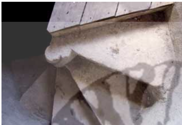
18. Avola. Chiesa di San Giovanni, particolare del gradino terminale della scala a chiocciola con occhio centrale con modanatura elicoidale articolata.
