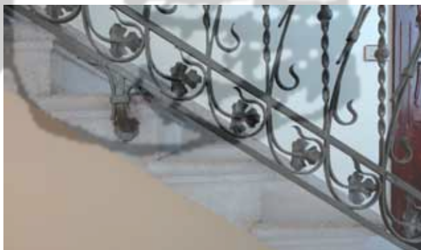
1-2. Trapani. Casa Ferrante, 1908, scala vista dall'alto e particolare del gradino.
