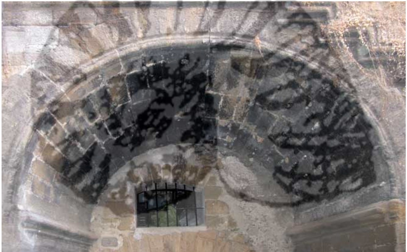
7. Particolare dell'arco abocinado a sostegno della scala.
