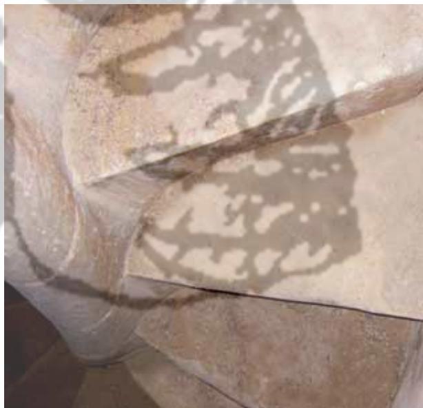
20-21. Noto. Chiesa di San Francesco d’Assisi all’Immacolata, accesso alla scala elicoidale e particolare del peculiare raccordo curvo tra la superficie verticale di alzata del gradino e il cordolo..
