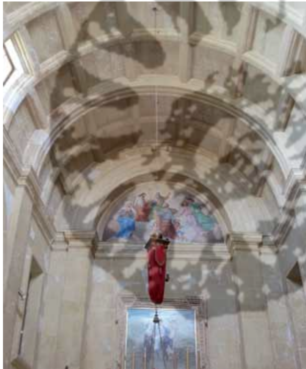
36. Cittadella di Gozo (Malta). Cappella di San Giuseppe (primi anni del XVII secolo?). Si noti l'indipendenza tra la calotta e le creste.
